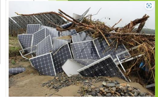
台風による水害で被災した太陽光パネルの例
